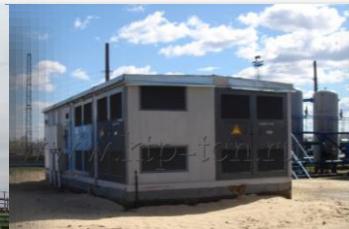
в бетонной оболочке
