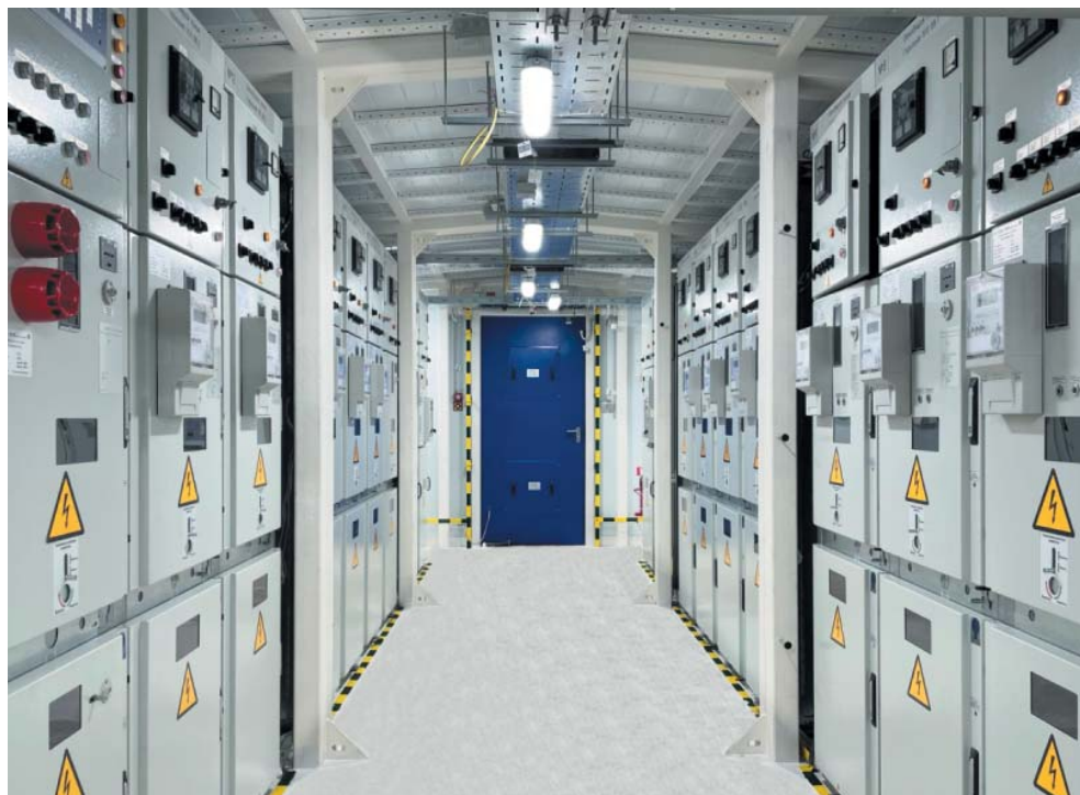
Рис. 1. Общий вид комплектного РУ типа "Каскад" в КТП
