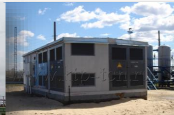
в бетонной оболочке
