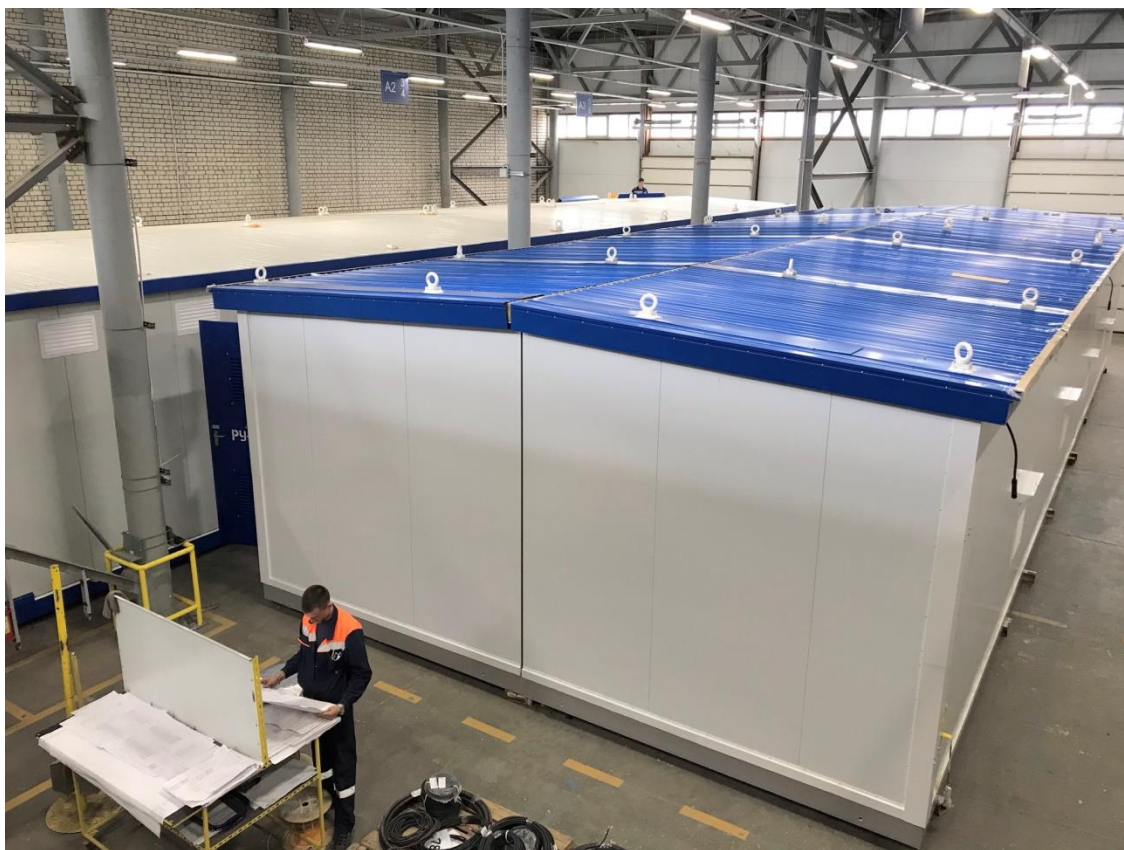
Рис. 1. Общий вид комплектной трансформаторной подстанции в заводском цехе сборки.
