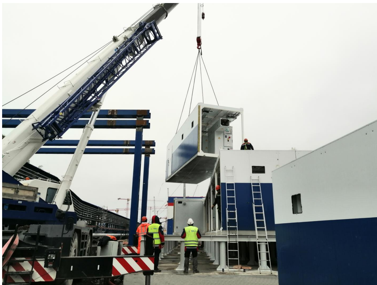
Рис. 2. Производство строительного-монтажных работ с блочно-модульными КТП на объекте.
