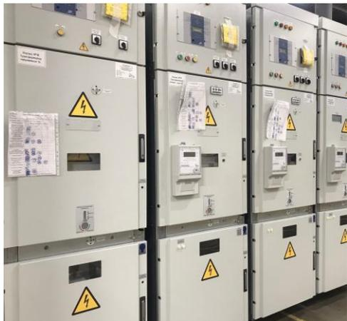
Вне зависимости от модификации внутренний объем КРУ разделен металлическими перегородками на четыре изолированных отсека, каждый из которых оснащен отдельным каналом для сброса избыточного давления
