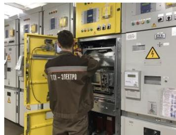
Безопасность эксплуатации КРУ обеспечивается системой встроенных блокировок в соответствии с требованиями ГОСТ и ПУЭ
