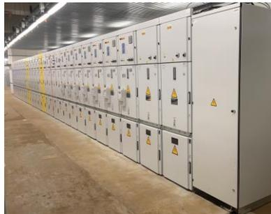
В рамках развития Московского метрополитена - при строительстве новых станций метро «ТСН-электро» осуществил поставку: РУ 20 кВ в составе 55 ячеек КРУ «Каскад»; РУ 10 кВ в составе 79 ячеек, 14 шкафов внешних подключений (ШВП).
