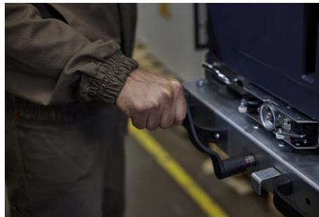
Выкат коммутационного элемента и обслуживание шкафа производится с помощью сервисной тележки, которая регулируется по высоте
