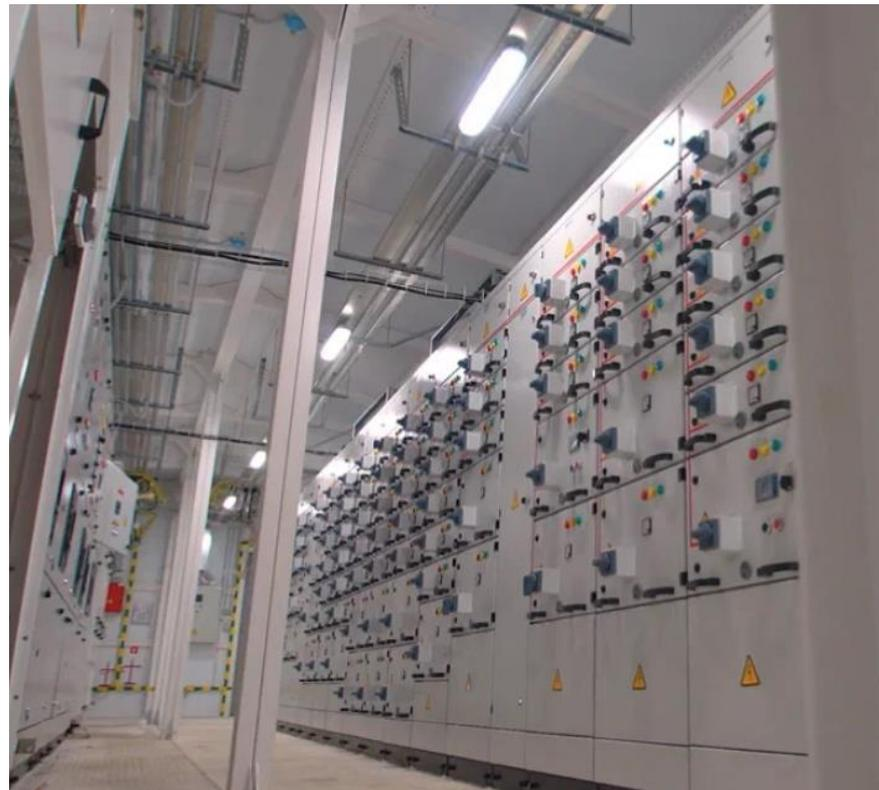
Архитектура построения АСУЭ в составе шкафа РУНН, шкафа гарантированного электропитания и щитов станций управления КРУ базируется на централизованном устройстве сбора данных – Концентраторе данных РУНН, который контролирует работу АВР, расцепителей, счетчиков, УКРМ, модулей ввода-вывода. Подключение УВН выполнено напрямую по протоколу Ethernet 100 BASE TX / МЭК 61850.
