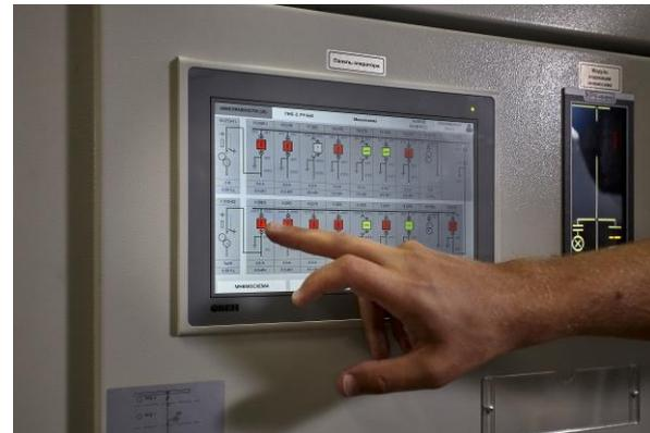
Блок управления АВР выполнен на программируемом контроллере и сенсорной панели оператора, которые обеспечивают реализацию возврата к нормальному режиму работы, контроль выполнения команд и контактной группы силовых выключателей, автоблокировку подачи напряжения на аварийную секцию. Дополнительно ПК - сбор и передача информации на верхний уровень по цифровому протоколу обмена в соответствии с концепцией цифровой КТП.
