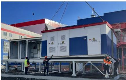
Распределительные устройства высокого напряжения (КРУ, КСО)
