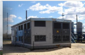
в бетонной оболочке
